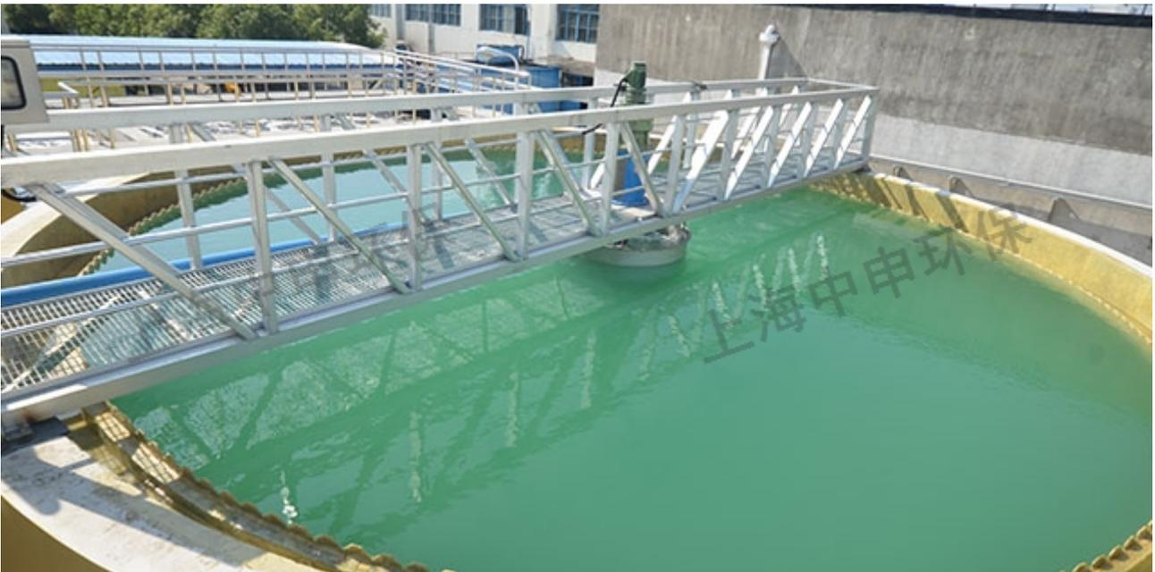
中心传动刮泥机采用中心传动、悬挂式，污水从工作桥下进水管流入导流筒扩散后，均匀的向周边呈辐射状流出，呈悬浮状的污泥经沉淀后沉积于池底，驱动装置带动中心立轴旋转，并带动刮臂及刮泥板转动，将污泥从池周刮向中心集泥槽后，靠池内静水压由排泥管排出池外，水面上的浮渣通过旋转撇渣装置撇向池边，再由刮渣耙刮进排渣斗内排出池外；而上清液则通过三角形出水堰板溢入出水槽内排出。驱动装置采用三级摆线针轮减速机传动，传动稳定，结构紧凑，机械效率高。全桥周边刮泥机源头直供厂家刮泥机批发厂家，认准上海中申环境工程有限公司！
